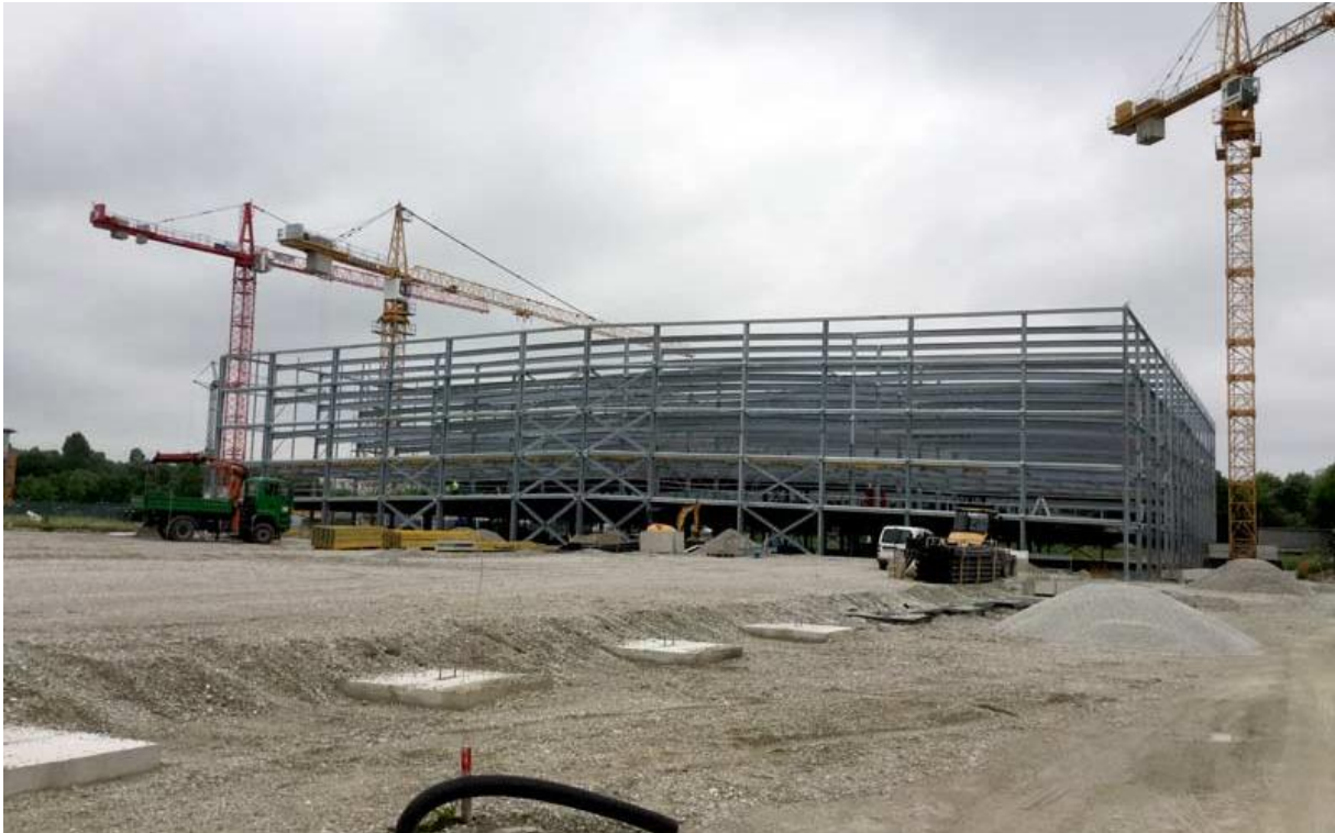
Abb.1: Baustelle eines Parkhauses Quelle: www.google.de Bilder
